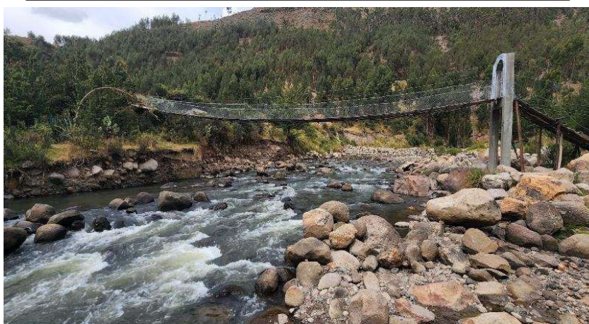
FIGURA N°03: VISTA DEL PUENTE PEATONAL ALEDAÑOS A LA RIVERA DEL RIO VINCHOS, LOS MISMOS QUE ESTAN SIENDO EROSIONADOS Y SOCAVADOS EN ÉPOCA AVENIDAS.
